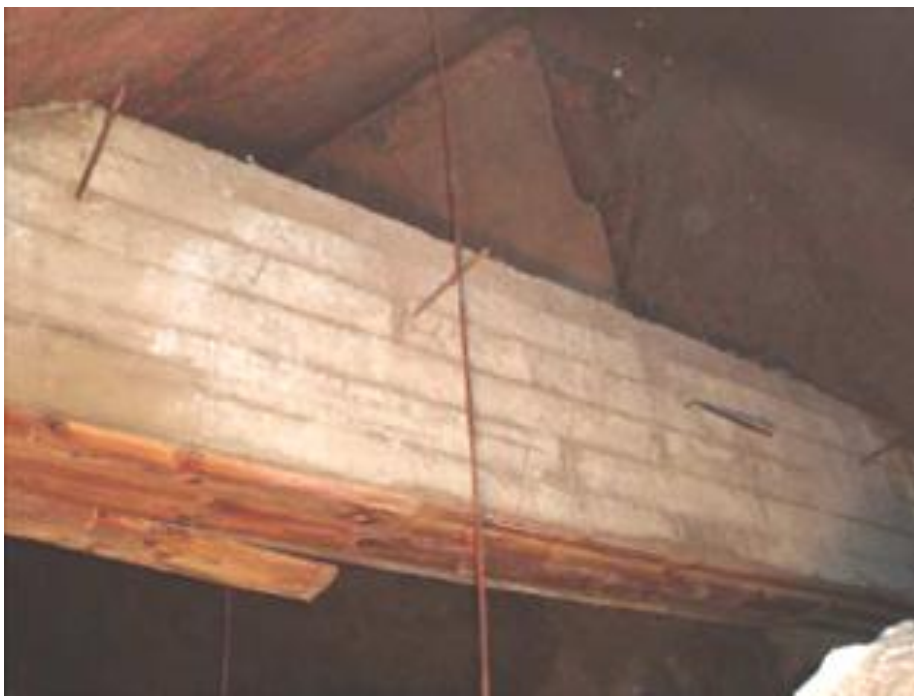
Figur 1 Utfall i tunneltak och förstärkning med hjälp av betongbalkar/strävor.
