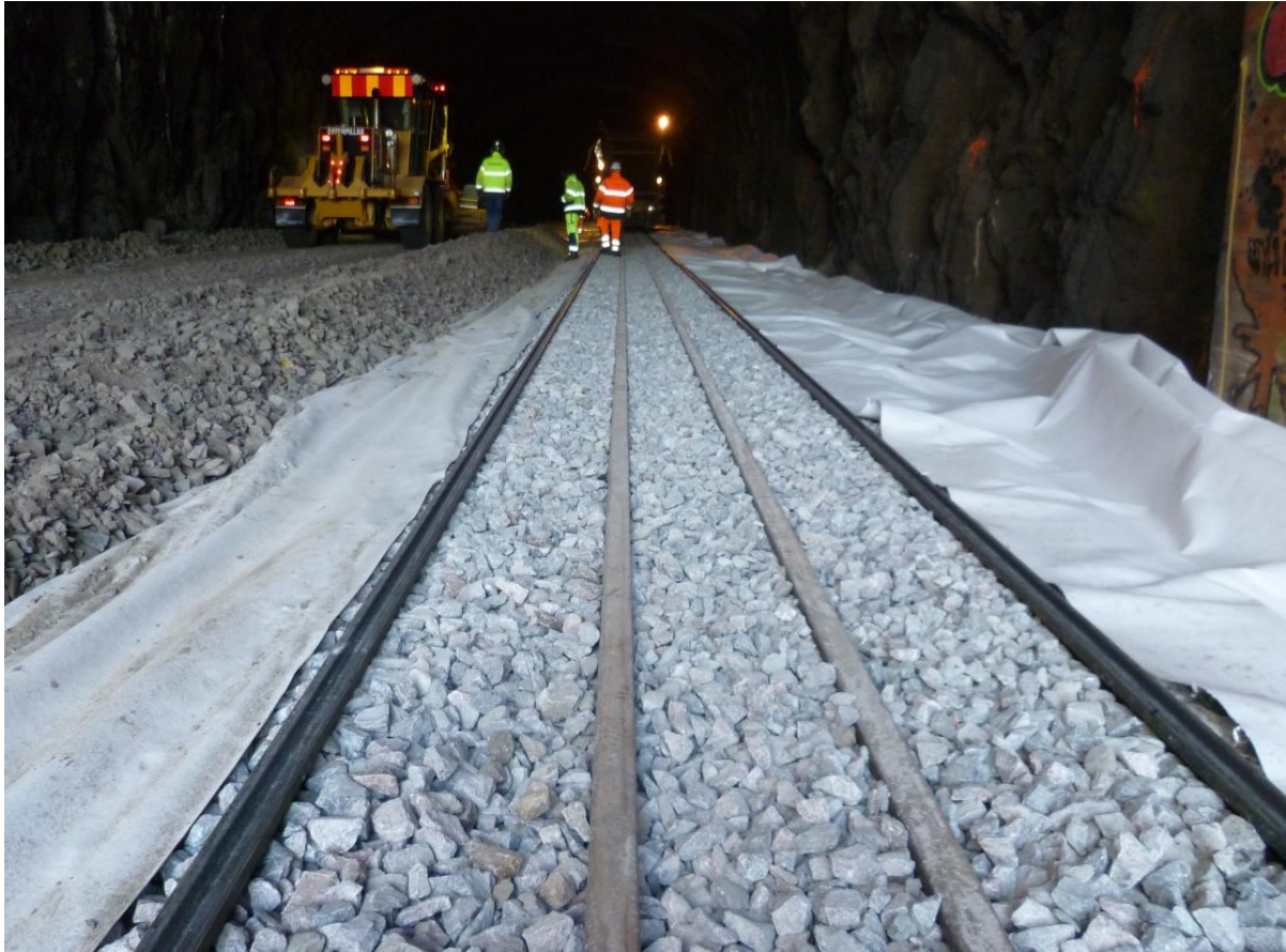
Figur 6 Provisorisk väg på spår. Makadam mellan spår över detta geotextil och bergkross.
